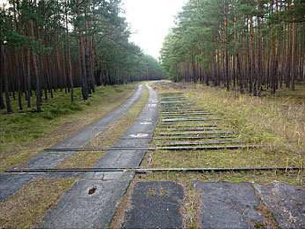
Ein Gleisübergang (Normalspurweite 1435 mm) mit einem niveaugleichen und einem etwa 7 cm frei liegenden Gleiskopf. Unmittelbar dahinter schließen sich über 21 m Länge 34 Bahnschwellen (Abstand ca. 35-45 cm) mit ebenfalls etwa 7 cm Freistand an.
