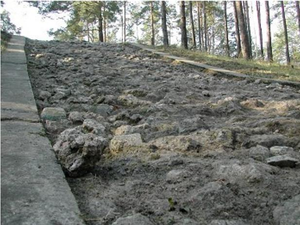
Fester Geröllhang\*): Steigung bis 35 %, Breite: 5,00 m, Länge: 35 m, Belag: Geröll, faust- bis kopfgroß in Beton fixiert
